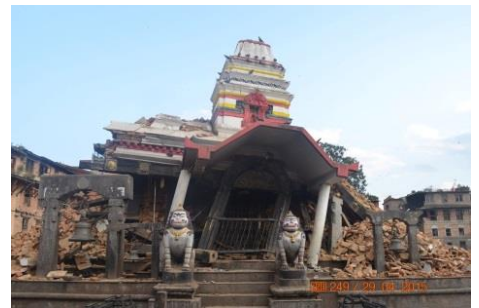
甚大な被害を受けた カトマンズ市（写真＝ネパール YMCA）
