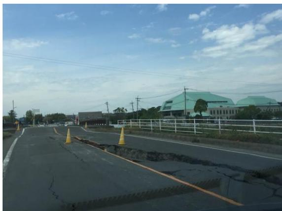
道路には亀裂が入り、交通網を寸断している
