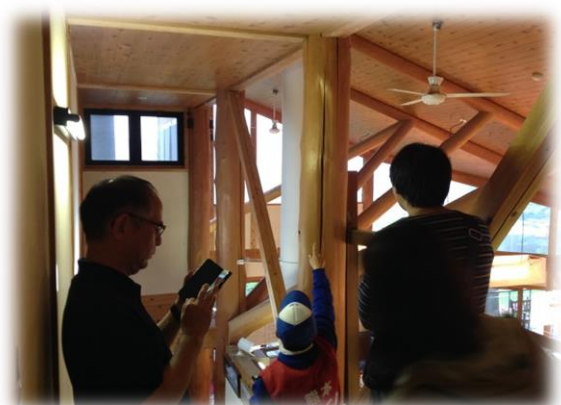
柱に亀裂が入った阿蘇YMCA。
