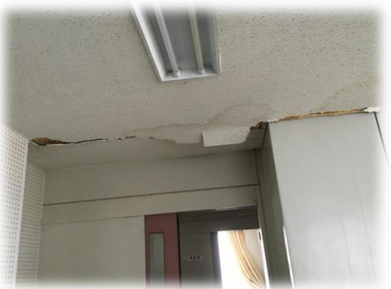
天井に亀裂が入った熊本YMCA本館。
