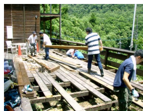
リトリートセンター研修棟デッキ床の改修工事
